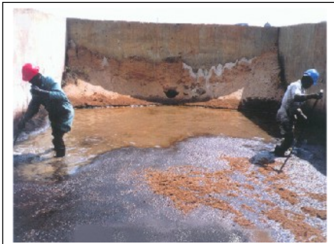
Foto 6: Avskummere brukes deretter for å sikre at vårt produkt får full kontakt med alt utsølte materialet i dammen. På fotoet ser en opprensingsfolk som skummer den innkapslede blandingen for innsamling.
